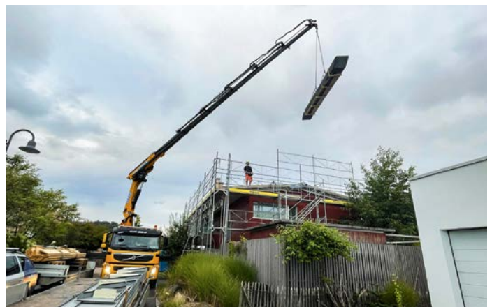
Der wirtschaftliche Logistikprozess umfasst die Planung samt entsprechender Beförderung der Profile auf das Dach bzw. zum jeweiligen Einbauort
